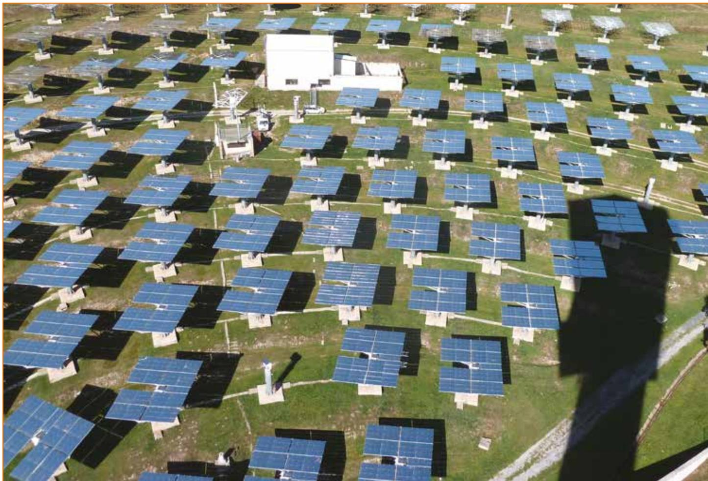
Photo 4. Vue du champ d'héliostats de Thémis. Nous sommes ici à 80 m au-dessus du sol. C'est à ce niveau, celui du récepteur central, que se mettent en place les expérimentations du programme PEGASE. L'ombre de la tour est visible sur la photo. Ici, les héliostats sont en position de repos. Ils sont pilotés par deux programmes informatiques couplés, un programme superviseur central et un programme embarqué dans chaque héliostat. Photo Serge Rambal.
